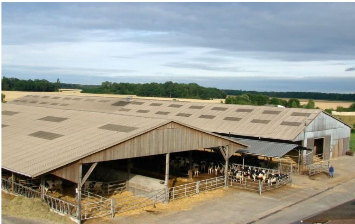
Bâtiments d'élevage – Ferme de Bressonvilliers – sources : nouvelleclair.fr
