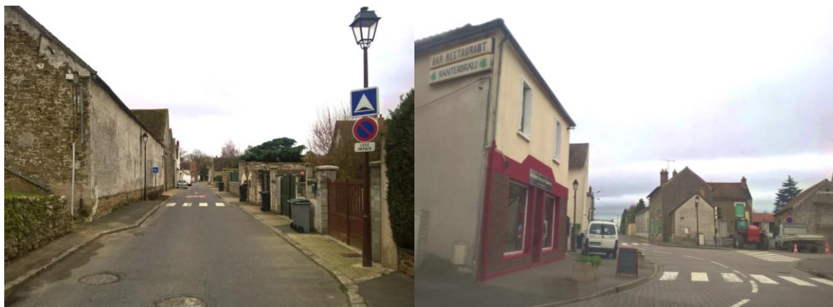
La rue de la Croix Boissée et le centre de Leudeville
